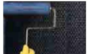
5. Oprima la lámina de fibra seca contra el saturante húmedo. Pásele un rodillo nervado (desespumante) para oprimirla contra la superficie. Aplique una segunda capa de saturante para permitir el encapsulado completo de las fibras.
