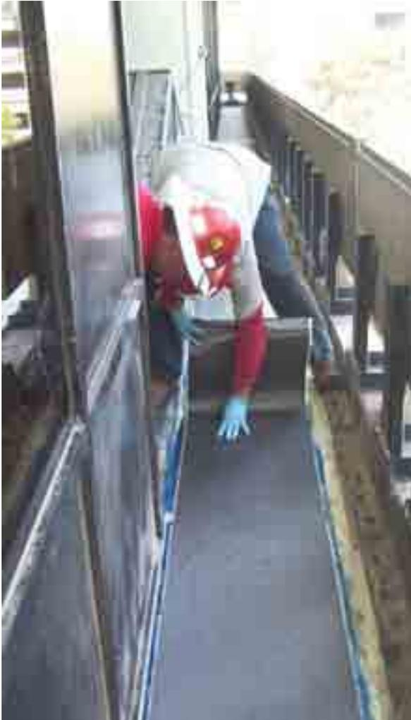
Repare cualquier área extensa del substrato de concreto que presente defectos tales como desconchados o delaminados, e inyecte todas las grietas del substrato. Prepare la superficie de concreto mediante técnicas de abrasión mecánica, proyección de agua a muy alta presión o esmerilado con disco.
