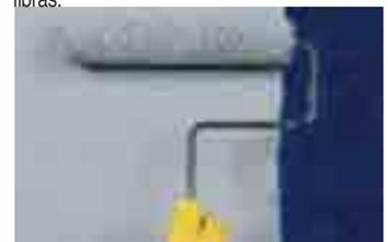
6. Repita la aplicación de capas de saturante-fibras-saturante según sea necesario. Aplique MBrace® Topcoat (opcional).
