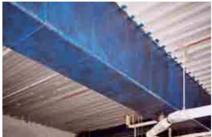
El refuerzo a cortante con MBrace® se puede colocar como tiras individuales de refuerzo. En algunos casos, se pueden cortar huecos en las alas o en la losa con lo que el refuerzo puede envolver por completo la sección.
