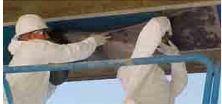
El sistema MBrace® puede aplicarse a paredes de concreto y mampostería para aumentar su resistencia a cargas fuera del plano, tales como aquellas debidas a vientos, presión del suelo, presión de fluidos en tanques y voladuras.
